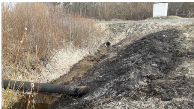
Pilt 1 – 20240327 Väike-Koru eesvoolu kraavi suubumine plasttruupi, Laagri-Hüüru kergtee L3.
